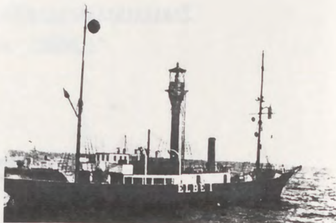
Feuerschiff 'Norderney I' übernahm am 31. Oktober 1936 die Position 'Elbe 1'. Bauwerft: AG Weser, Baujahr: 1906/07, Länge: 46,00 m, Breite: 8,00 m. Auf Station: bis 7. November 1948. Nach diversen Umbauten zuletzt bis 23. September 1981 auf der Station 'Weser', jetzt Museumsfeuerschiff in Wilhelmshaven.
